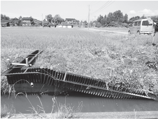
写真5 魚道の設置
